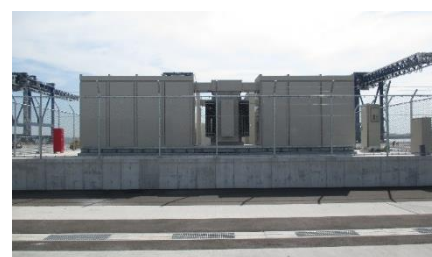
図 53 電源設備の嵩上げ
