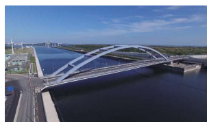
海の森大橋 (令和2年6月20日開通) Umi-no-Mori Ohashi Bridge (Open June 20, 2020)
