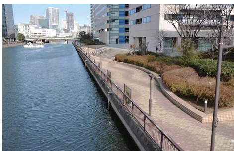
内部護岸 Interior Embankment
