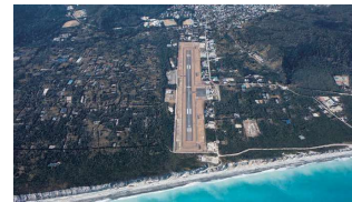
新島空港 Nijima Airport
