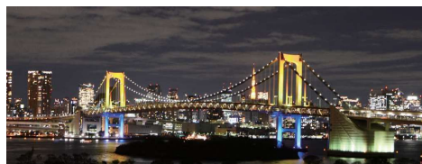
レインボーブリッジ (平成5年8月26日開通) The Rainbow Bridge (Open August 26, 1993)
