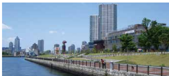
防潮堤 Tide Embankment
