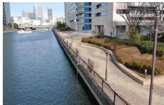
高浜運河（内部護岸） Takahama Canal (Interior embankment)
