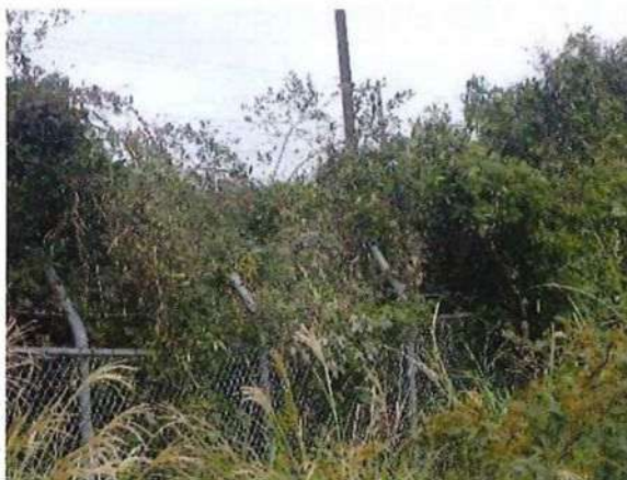
枝の撤去、及び有刺鉄線の補修を実施。 ※詳細：別紙5参照
