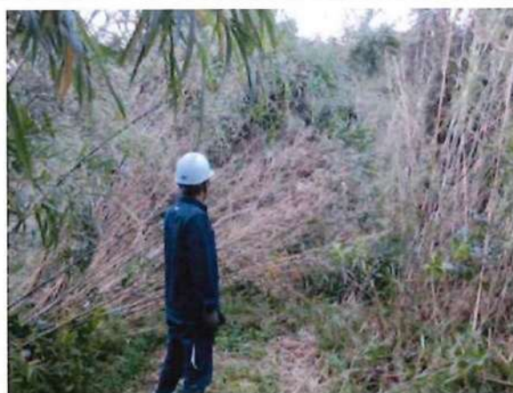
航空障害灯 B の分電盤までの通路確認。倒木が著しい。
