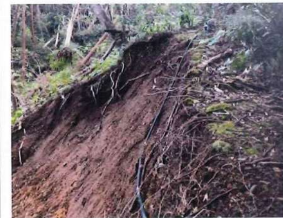
航空障害灯 C までの通路、大きく崩落している箇所もあるが、灯柱まで到達し点灯を確認。
