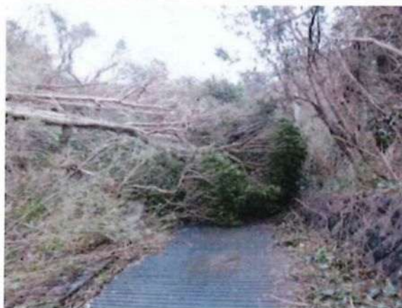
倒木が多い箇所は自力での撤去が困難であり、一部は外部委託にて撤去を実施。
