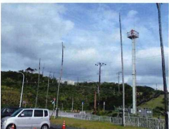
駐車場のヤシの木の多くは芯頭が脱落。いずれ倒木の危険があるため、後日、外部委託にて伐採。
