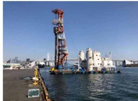
図 3-4 地盤改良工の施工例
