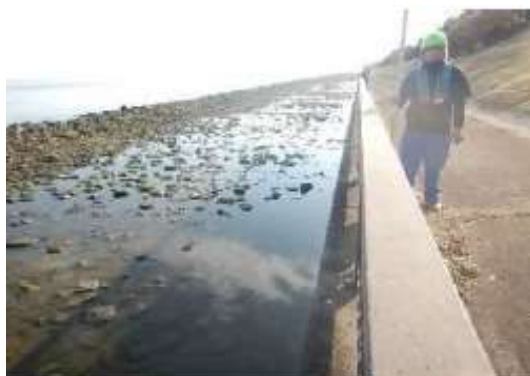
図 2-9 護岸の目視点検（陸上部）
