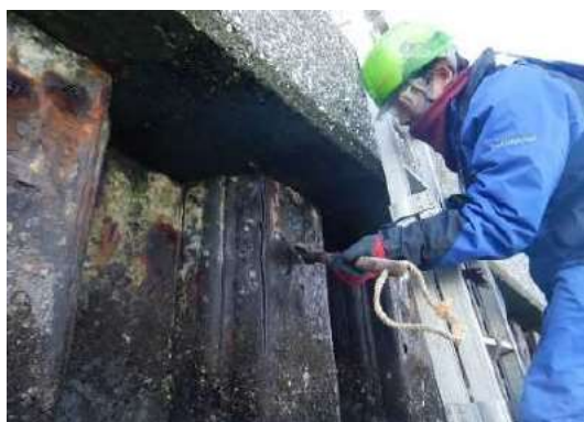
図 2-10 鋼矢板護岸のケレン作業（海上部）
