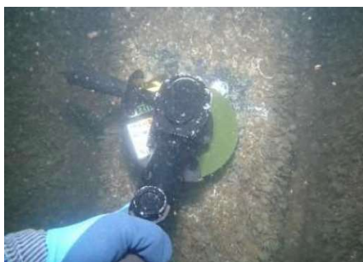
図 2-12 潜水による水中のケレン作業（海中部）
