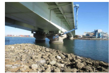
劣化調査状況 (城南大橋)
