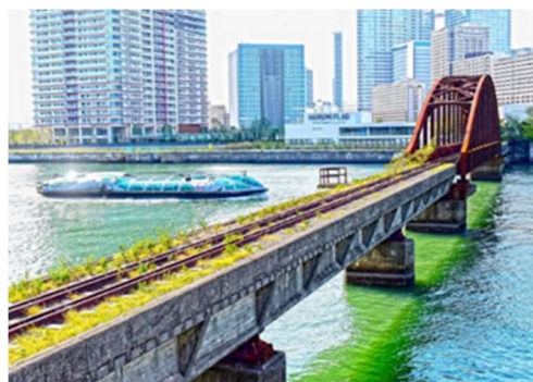
土木遺構（旧晴海鉄道橋）
