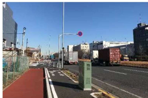
臨港道路の無電柱化
