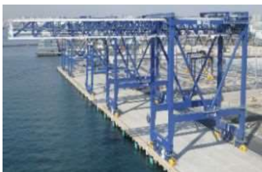
耐震強化岸壁・免震クレーン
