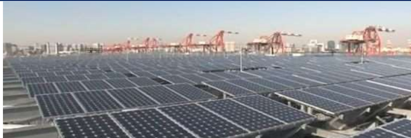
（例）大井コンテナふ頭ゲート屋上 大井コンテナふ頭立体格納庫屋上
