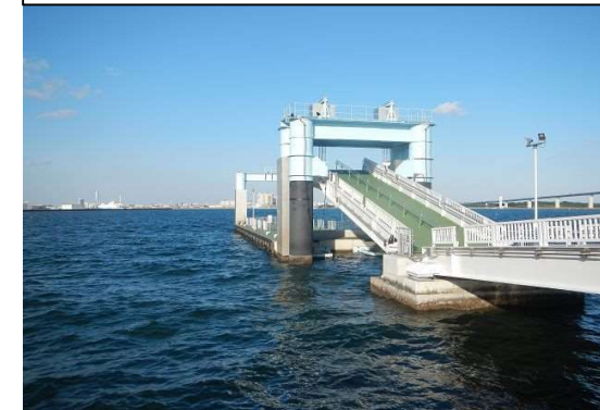
海の森公園船着場【港湾局】 (令和2年7月完成)
