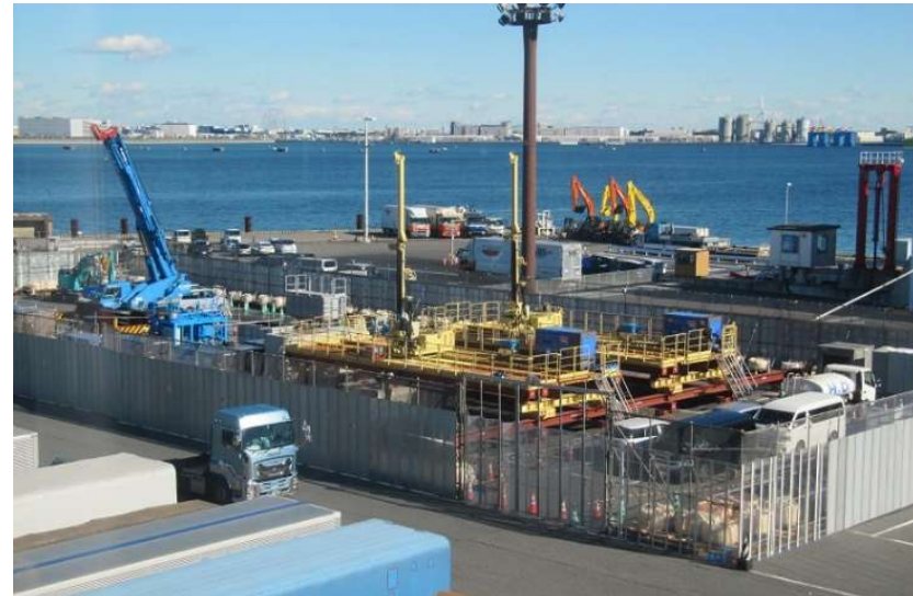
陸上部の地盤改良状況
