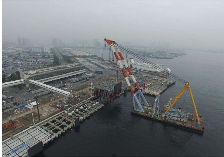
起重機船による据付状況(施工済)
