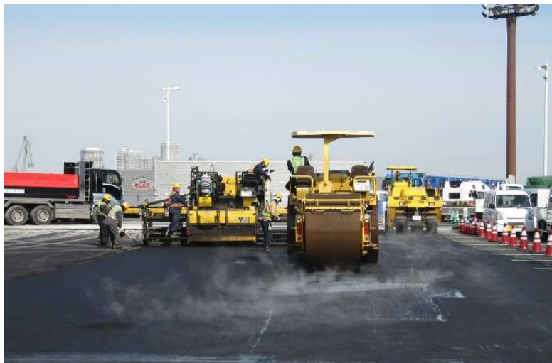
舗装工事の状況
