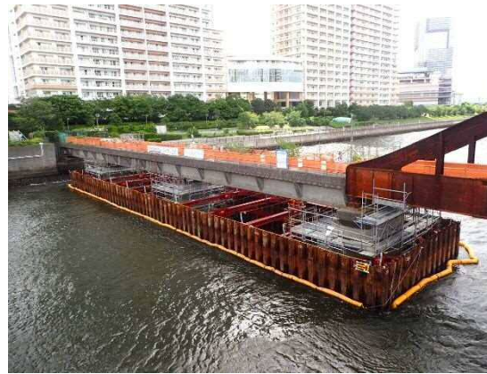
仮締切設置完了 令和4年8月
