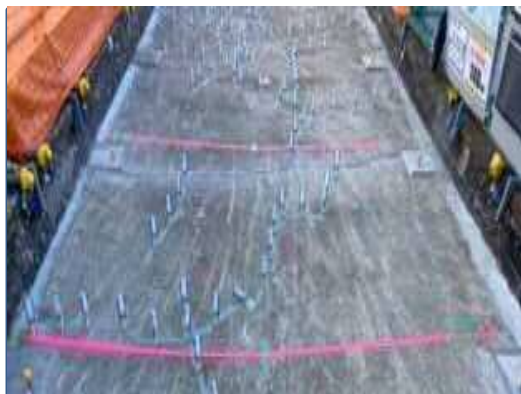
ひび割れ補修状況 令和6年1月
