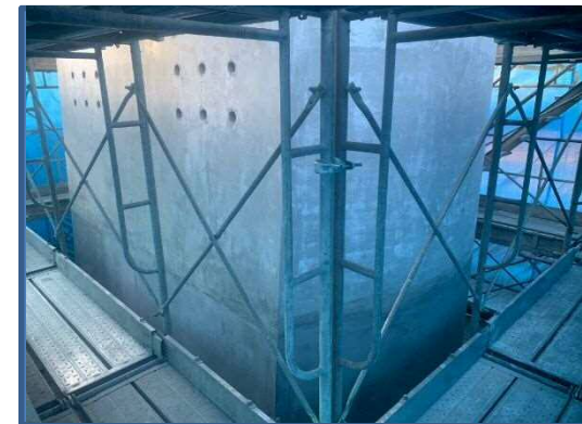
橋脚補強工（乾式吹付完了） 令和4年1月
