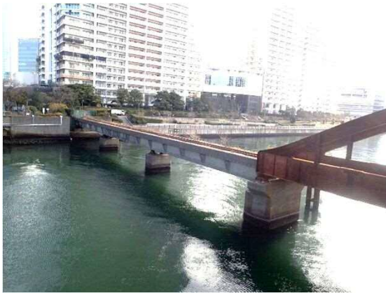
着工前 令和4年2月
