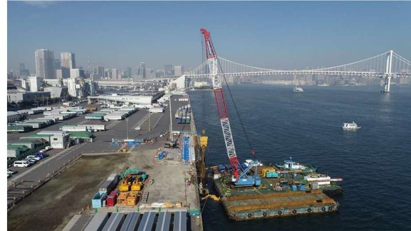
鋼管矢板の打設状況
