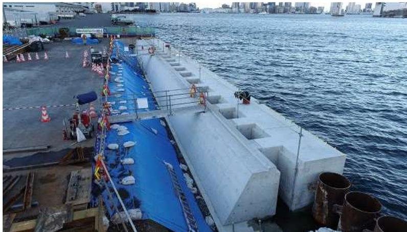
上部工のコンクリート打設が完了した状況
