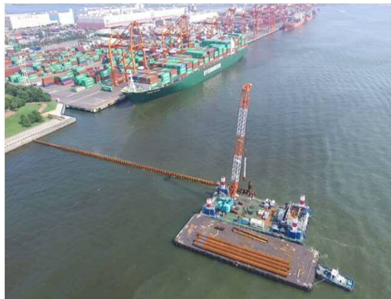
鋼管矢板打設 平成28年9月
