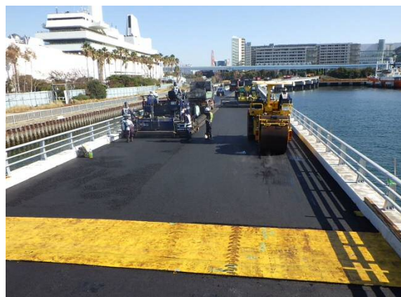
橋面舗装 平成30年10月
