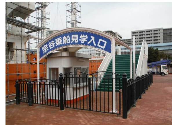
カットハウス・入口階段新設 平成28年12月
