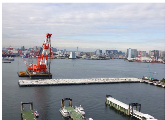
鋼管杭打設 平成30年11月
