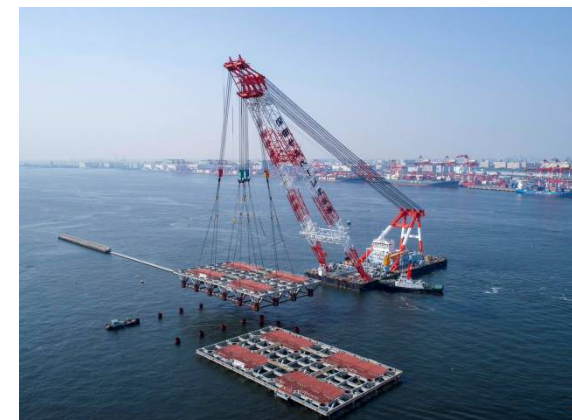
ジャケット据付 平成30年4月
