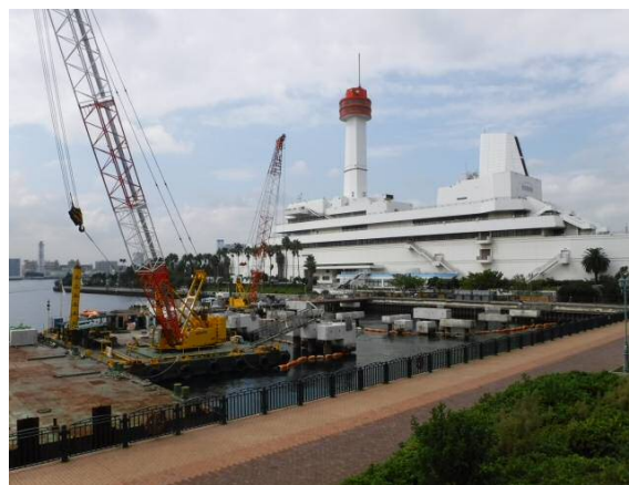
既設係留施設撤去 平成28年10月
