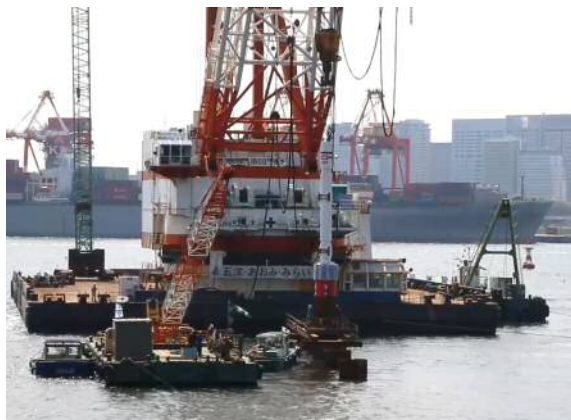
鋼管杭打設 平成30年4月
