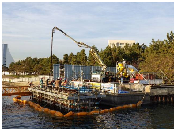
受梁コンクリート打設 平成30年12月
