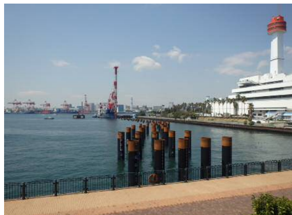
鋼管杭打設 平成29年4月
