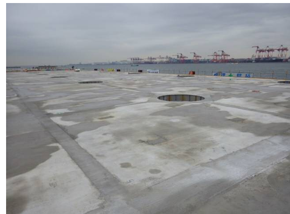
間詰コンクリート打設完了 平成31年1月
