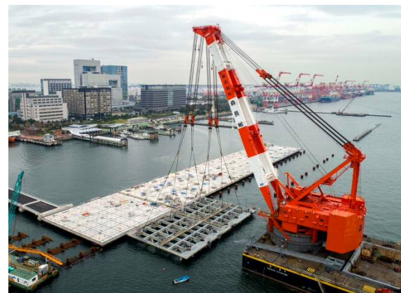
ジャケット据付 平成30年11月
