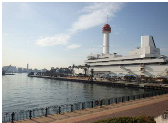
工事着手前 平成29年3月
