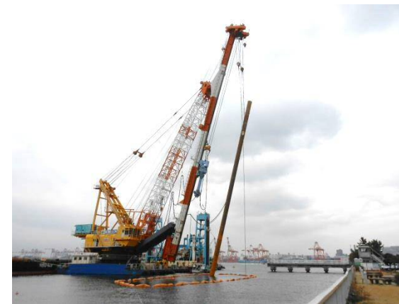
鋼管杭引抜 平成28年2月
