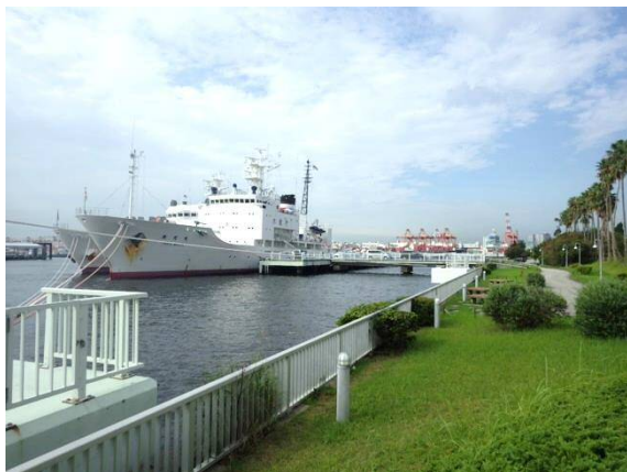
栈橋等撤去着手前 平成27年10月
