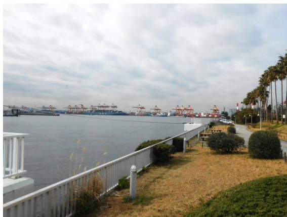
栈橋等撤去完了 平成28年2月
