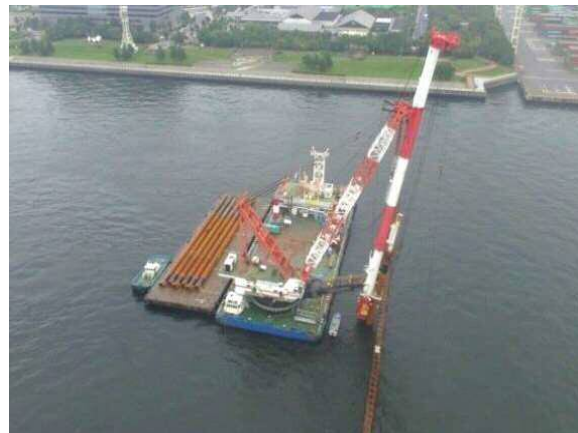
鋼管杭打設 平成28年9月
