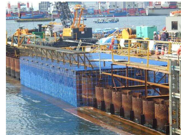
上部コンクリート打設前準備 平成28年12月
