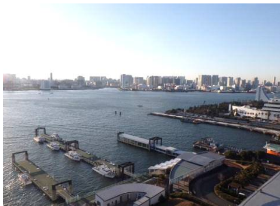
工事着手前 平成29年12月
