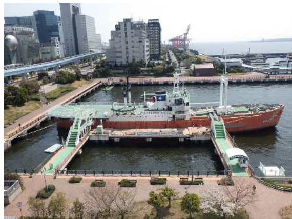
工事着手前 平成28年3月
