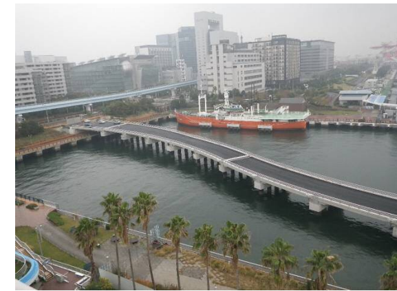
連絡通路車道部完成 平成30年11月
