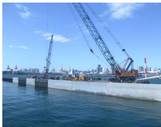
上部コンクリート施工 平成29年1月
