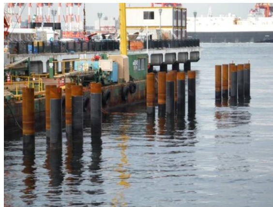
新係留施設（鋼管杭打設） 平成28年7月
