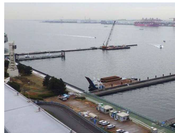
上部コンクリート施工 平成30年12月
