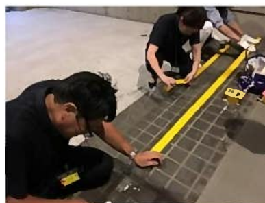
危険を予知し安全対策を実施
