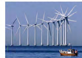
エネルギー供給施設
