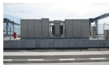
図 53 電源設備の嵩上げ
