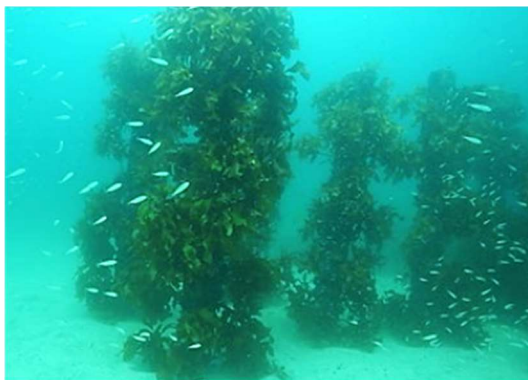
図 3-7 造成ブロックによる藻場整備
