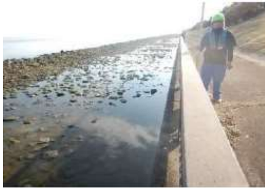
図 2-9 護岸の目視点検（陸上部）
