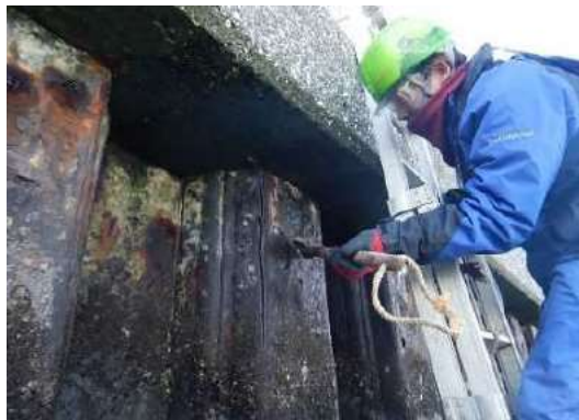
図 2-10 鋼矢板護岸のケレン作業（海上部）
