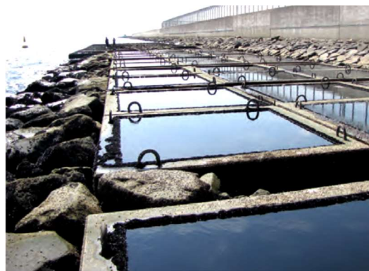
図 3-10 新海面処分場 (タイドプール)
