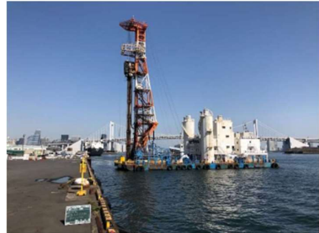
図 3-4 地盤改良工の施工例
