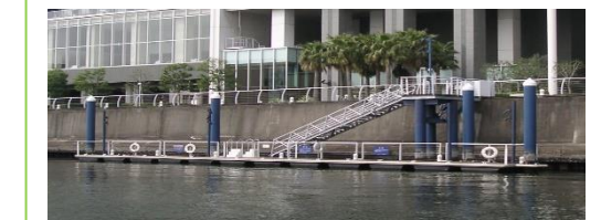
ワールドシティタワーズ栈橋
