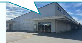
Airソーラー等の設置 (出典)積水化学工業株式会社(吹出中央)株式会社パワーエックス(吹出右)ウェブサイト
