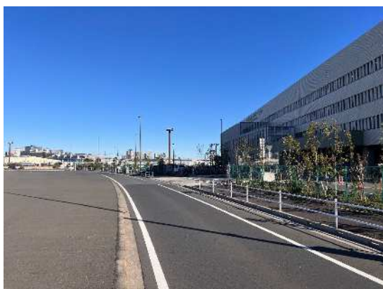
図 4-1 有明ふ頭連絡線の無電柱化
