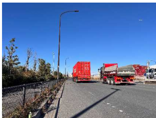
図 4-2 中防外1号線の無電柱化
