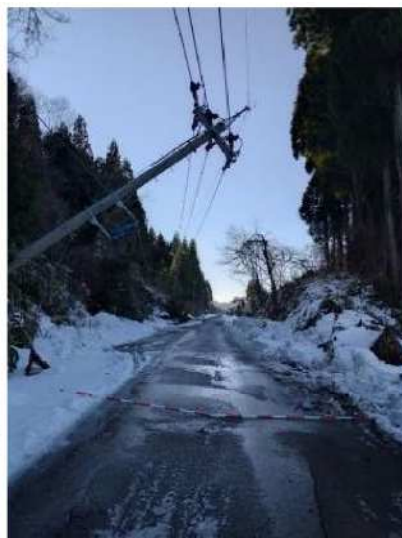
石川県輪島市 広域農道
