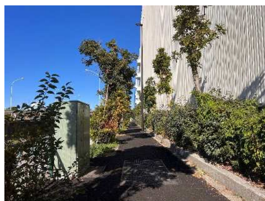
図 4-4 大井3号線の無電柱化
