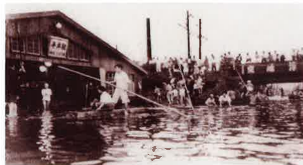
【昭和24年 キティ台風による被害状況(江戸川区平井)】
