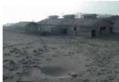
2000.8.20 撮影 降灰・噴石被害(村営牧場)
