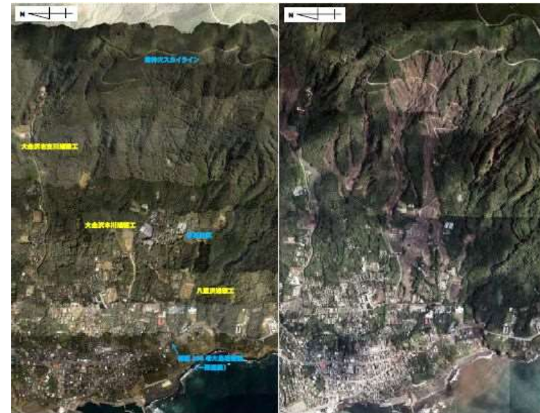
(左：土砂災害発生前、H24.4 国土地理院撮影、右：土砂災害発生後、H25.10.17 東京都撮影) 出典：平成 26 年 3 月 伊豆大島土砂災害対策検討委員会
