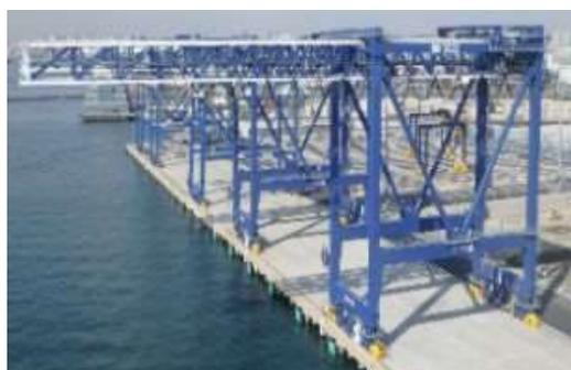
耐震強化岸壁・免震クレーン
