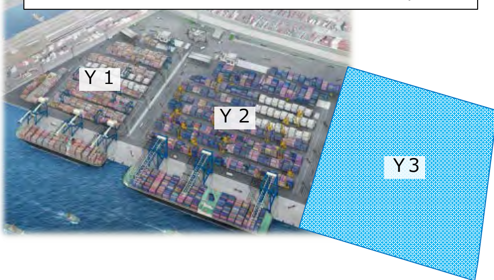
中央防波堤外側コンテナターミナル（Y1・Y2・Y3）
