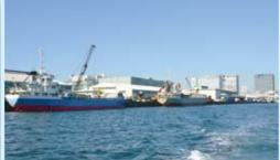
外貿在来船の主力ふ頭で、全長1.8km、15,000トン級 バースが9バース供用されています。鉄鋼、各種機械、 木材、紙、果物など多種多様の貨物を取り扱っていま す。また、背後には多くの上屋、民間倉庫が整備され、 ふ頭と一体的に効率的な荷さばきを行っています。
