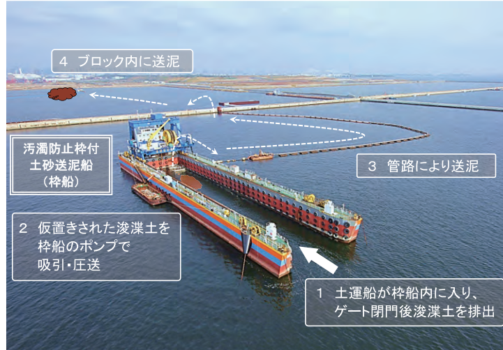
しゅんせつ土の送泥状況
