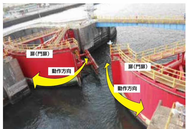
【セクターゲート(新砂水門)】
