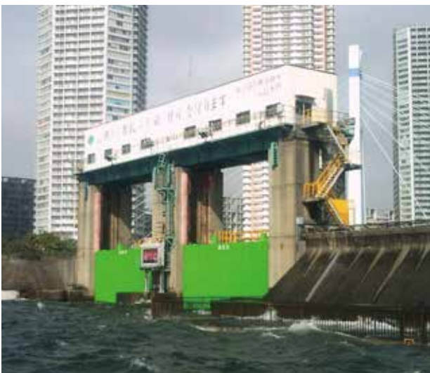
【台風による水門閉鎖状況(辰巳水門)】
