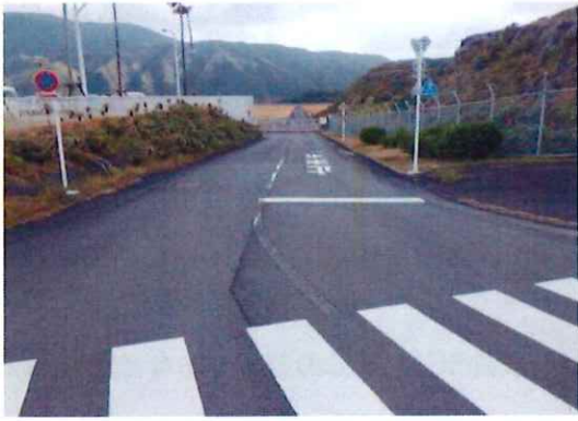
作業前の貨物側出入口中央線
