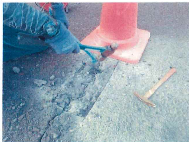
補修箇所周囲にカット施工
