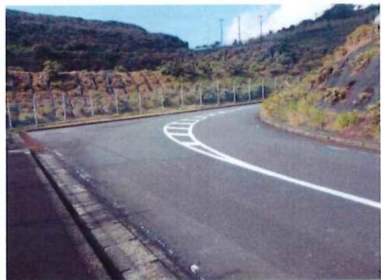
作業後の貨物前道路中央線(カーブ地点)
