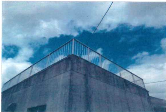
本復旧後の状態
