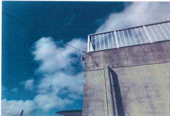
仮復旧の状態
