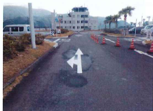
作業後の駐車場入口矢印
