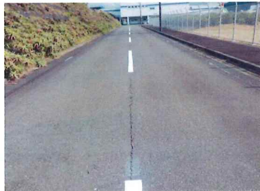
作業後の貨物前道路中央線(直線部)
