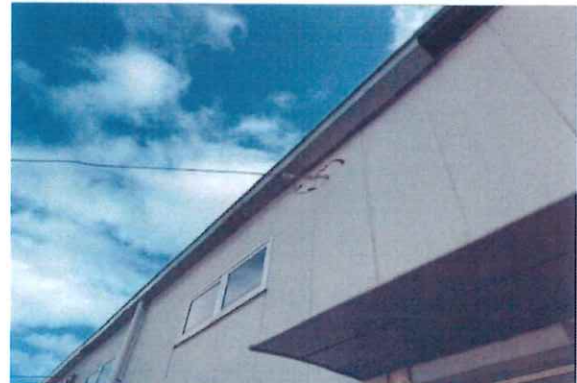
仮復旧の状態
