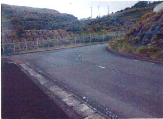
作業前の貨物前道路中央線(カーブ地点)
