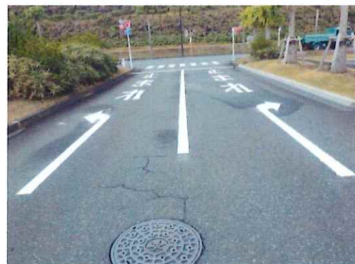
作業後の駐車場出口矢印・中央線
