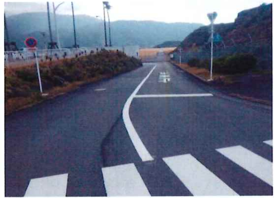
作業後の貨物側出入口中央線
