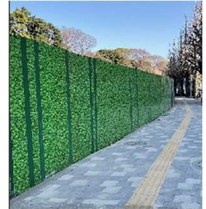
仮囲いフェンス(準備工)
