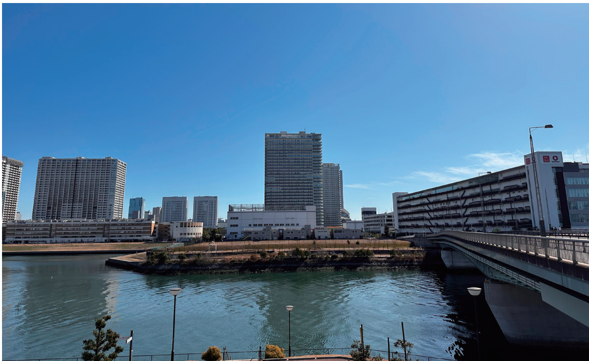
2 区域の補助 315 号線付近
