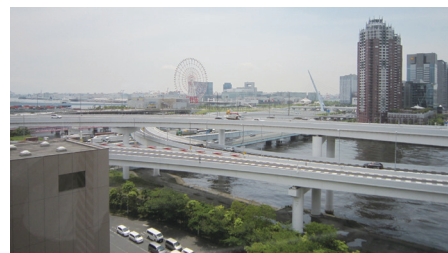
首都高速湾岸線付近
