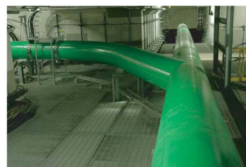
ごみ処理（管路収集システム）
