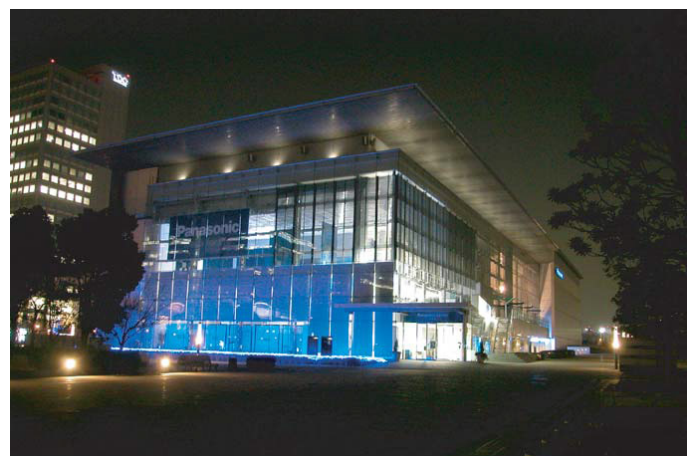
シンボルプロムナード沿いの施設の夜間照明
