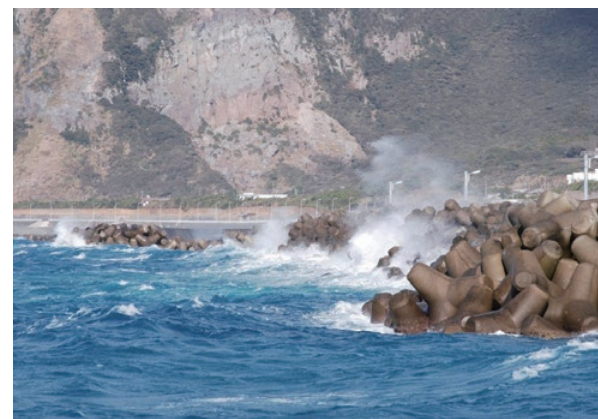
新島港海岸の離岸堤（新島） Offshore breakwater on the Nijima Port coast (Nijima)
