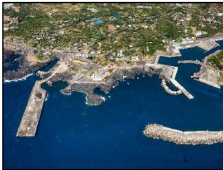
八重根漁港海岸全景
