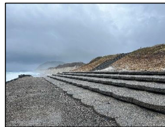
羽伏浦海岸の護岸
