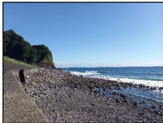
横間ヶ浦海岸の状況
