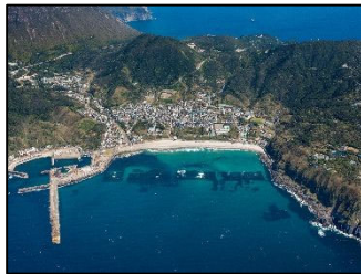
神津島港海岸全景
