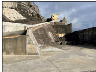
青ヶ島港の施設
