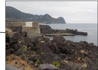
八重根漁港海岸の防潮堤
