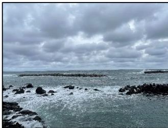
洞輪沢漁港海岸の離岸堤
