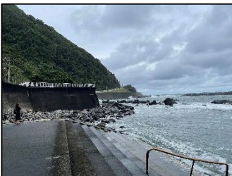
洞輪沢漁港海岸の護岸
