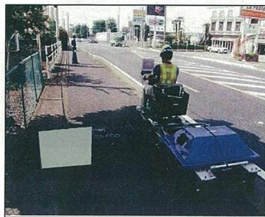
探査機による埋設管の確認作業
