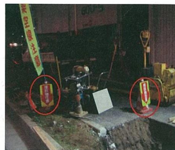
地下埋設物の目印表示（看板）
