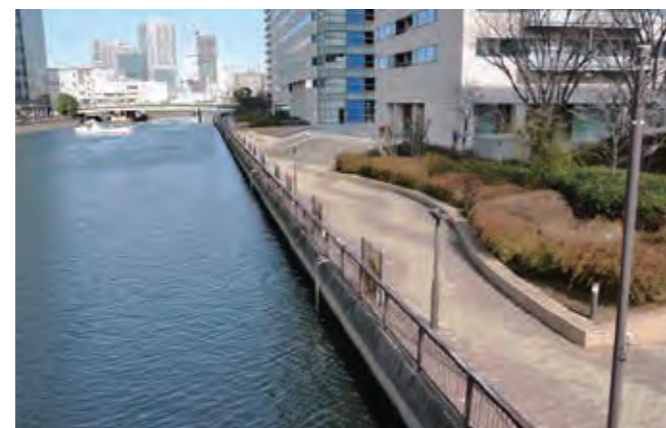
内部護岸 Interior Embankment
