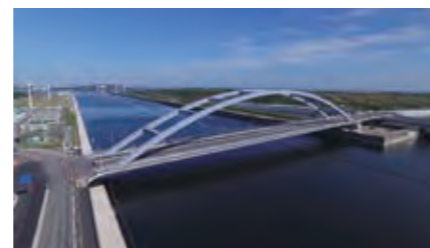
海の森大橋 (令和2年6月20日開通) Uminomori-hashi Bridge (Open June 20, 2020)
