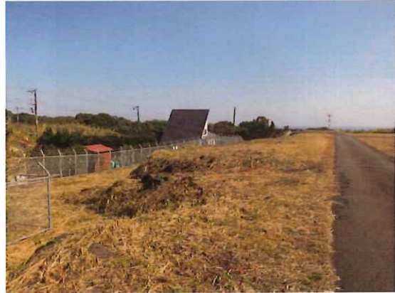
⑨区域の作業前
