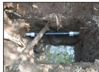
【該当箇所を迅速に修繕】
