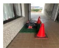
《トイレポンプ用発電機設置》
