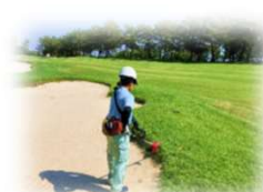
バンカー 排水改善及び景観向上 特殊機械による排水改善に加え、 ふち切り等により美しい景観をつくる
