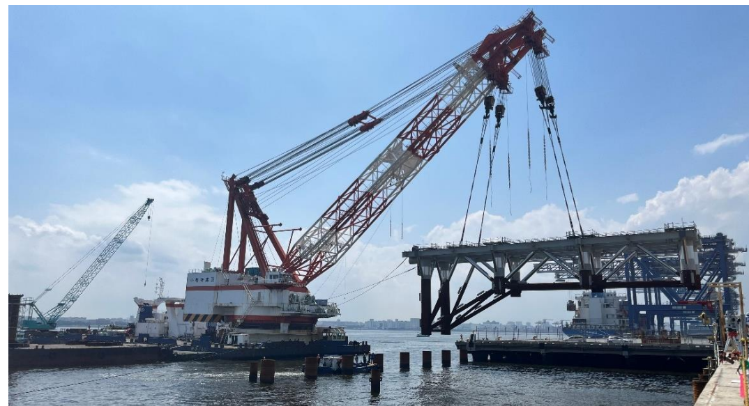
Y 3 の施工状況 (ジャケット据付)
