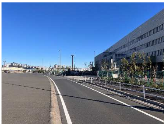
図 4-1 有明ふ頭連絡線の無電柱化
