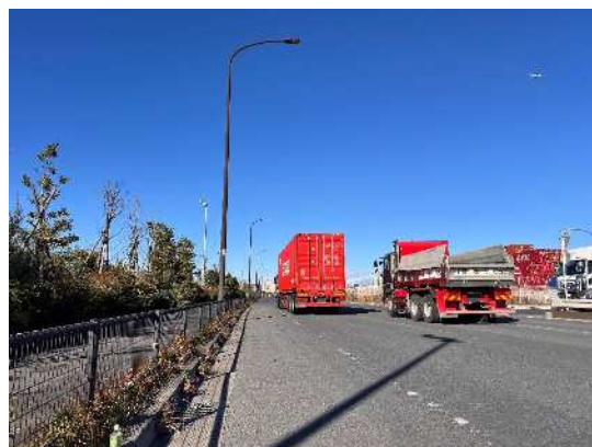
図 4-2 中防外1号線の無電柱化
