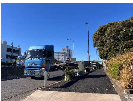
図 4-3 大井2号線の無電柱化
