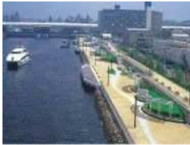
千葉港海岸(船橋地区)
