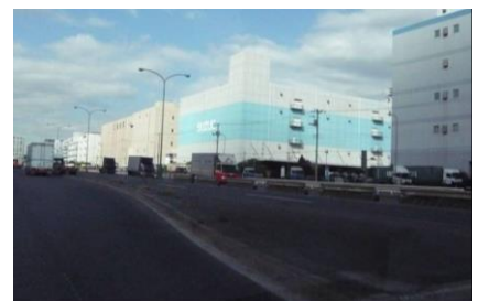
(参考) 道路からみた青海ふ頭周辺の倉庫群
