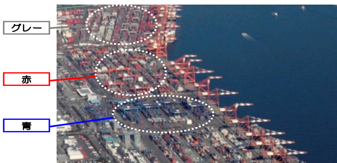
バース単位で使い分けられているトランスファークレーンの色彩（大井ふ頭）
