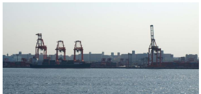
倉庫や上屋等の施設は、海上の視点からはガントリークレーンの背後に、群として眺められる。（写真は大井ふ頭）
