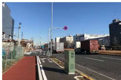
臨港道路の無電柱化
