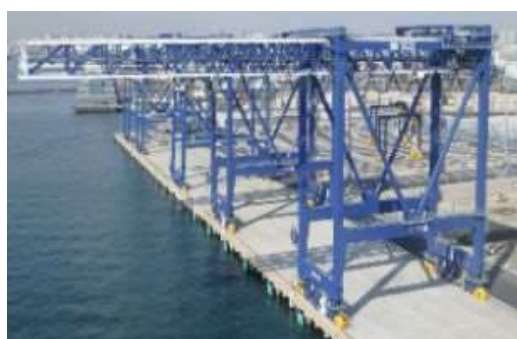
耐震強化岸壁・免震クレーン
