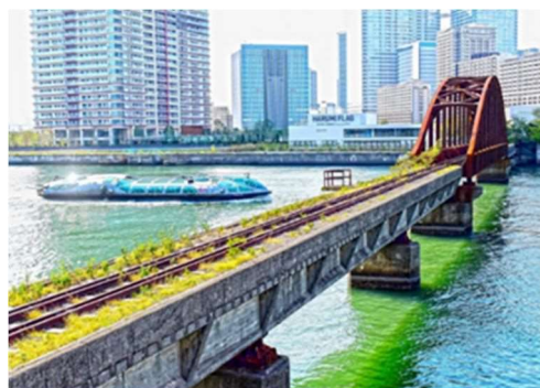
土木遺構（旧晴海鉄道橋）
