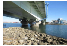
劣化調査状況 (城南大橋)
