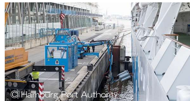
ドイツ・ハンブルク港での陸上電源供給の状況
