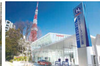
水素ステーション
