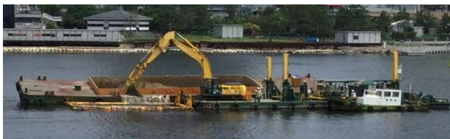
バックホウ台船による覆砂の状況
