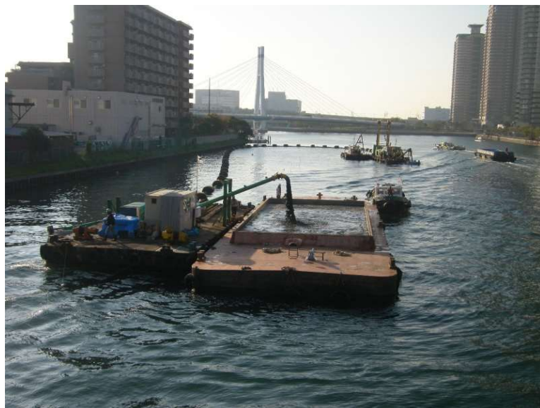
ポンプによる汚泥しゅんせつの状況
