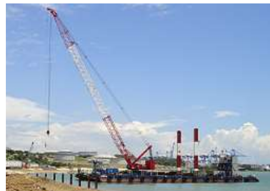
海上工事での資材の吊上・据付
