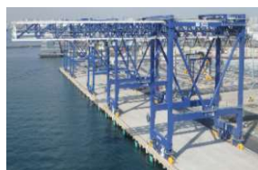
耐震強化岸壁・免震クレーン
