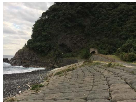
行者海岸<行者浜>(一般海岸) 海岸は礫浜であり階段護岸が整備されている
