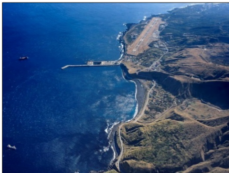
三池港海岸（港湾海岸） 海浜が侵食されている
