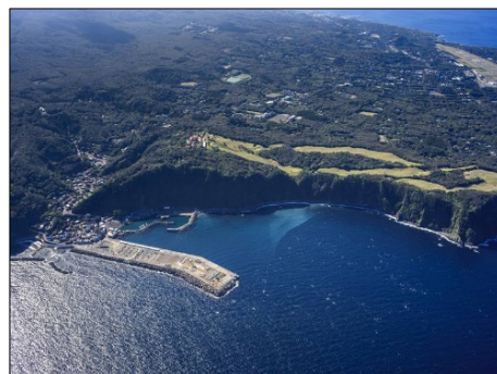
岡田漁港海岸（漁港海岸） 風化や台風等の高波浪により崩壊・侵食した土砂の堆積がみられる崖状の海岸
