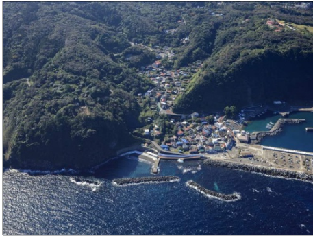
岡田港海岸(港湾海岸) 離岸堤、突堤及び人工海浜が整備され、海水浴場として利用されている海岸
