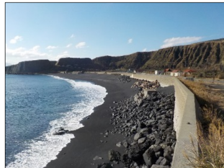
三池港海岸（港湾海岸） 既設防潮堤の背後の平地に集落がある
